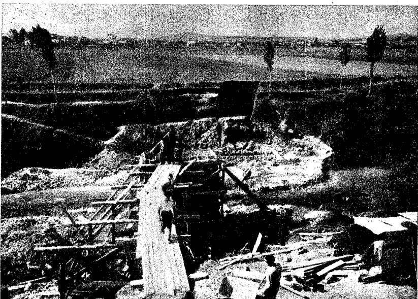
Puente en construcción para el ferrocarril que unirá las fábricas con la estación de Miranda
